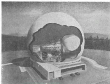
Fig. 3 - Vista della sezione di un'antenna mobile gigante a cono. L'apertura è di 3600 pollici quadrati. La protezione è sostenuta mediante aria ed ha un diametro di circa 200 piedi.
